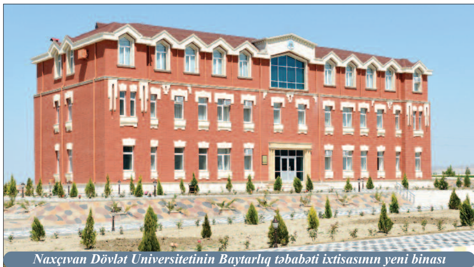
Naxçıvan Dövlət Universitetinin Baytarlıq təbabəti ixtisasının yeni binası
