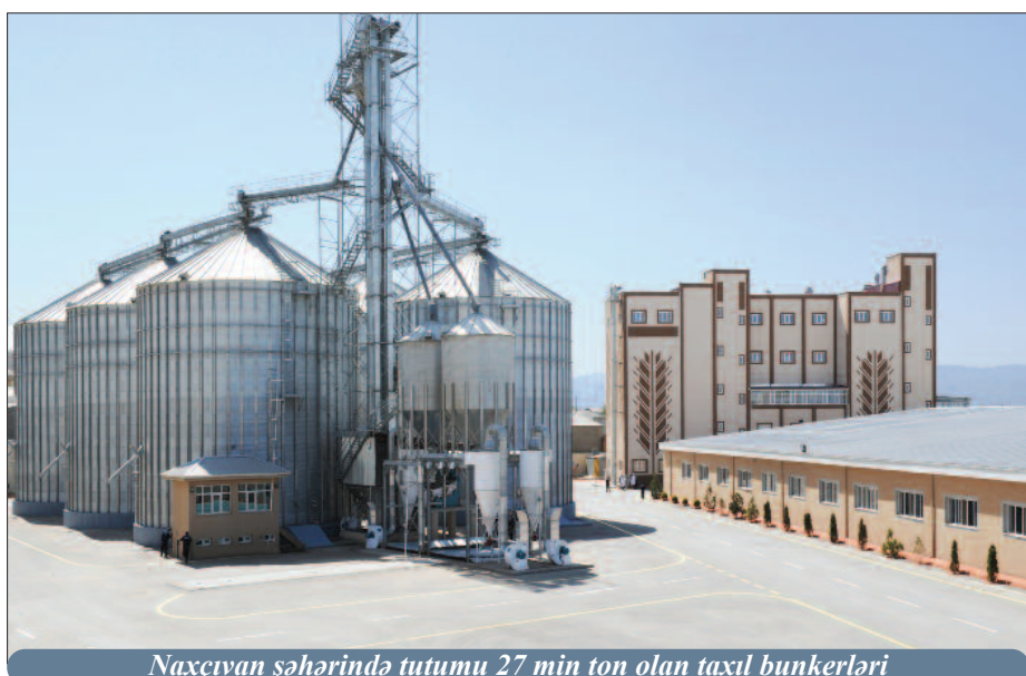
Naxçıvan şəhərində tutumu 27 min ton olan taxıl bunkerləri
