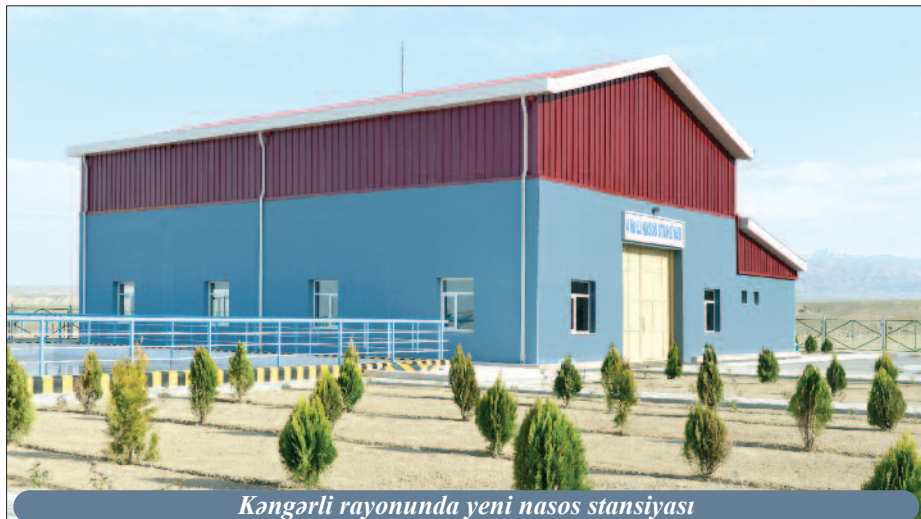
Kəngərli rayonunda yeni nasos stansiyası
